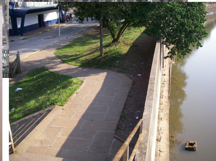
Dique separando a rodoviária de Leopoldo à esquerda e o rio dos Sinos à direita. Comparação dos dias 08 de maio (cota do rio com 5,35 m) e 22 de maio (cota do rio com 0,80 m) Coordenadas Geográficas: 29° 45' 35.42" S e 51° 8' 53.61" O Datum: WGS84 - Azimute 220°
