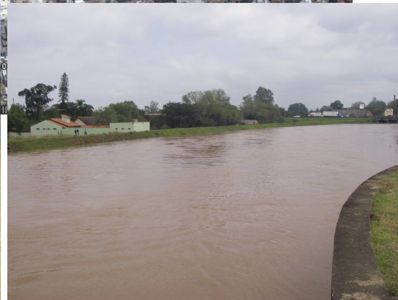
Casa situada abaixo do nível do canal de descarga do rio dos Sinos
