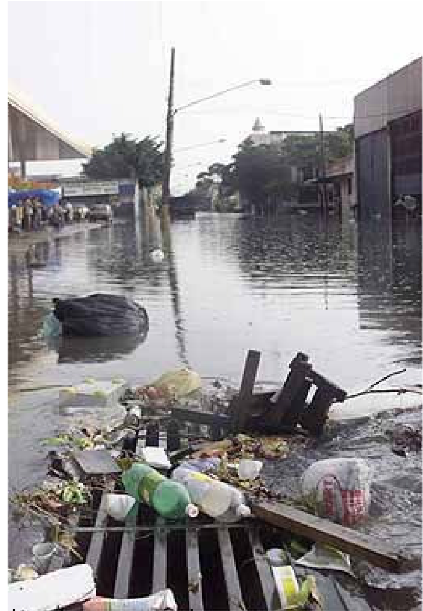
Alagamentos devido a problemas na microdrenagem urbana
